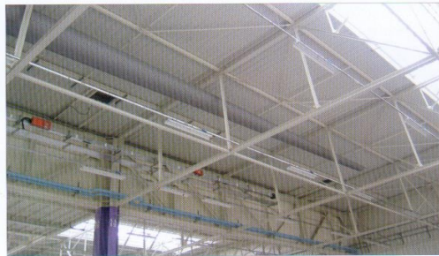
L'atelier de "ferrage" du constructeur automobile est chauffé par des centrales make-up en tout air neuf. L'air est diffusé par un réseau de 449 m de conduits textiles de forme tronconique. Ces conduits jouent un rôle actif en permettant notamment d'éviter les courants d'air et les phénomènes de stratification de températures.
