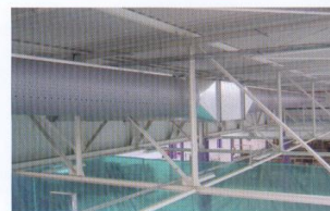
Les conduits sont alimentés par six centrales make-up de 90 000 m 3 /h fonctionnant en tout air neuf, installées sous la toiture, dans la charpente,
